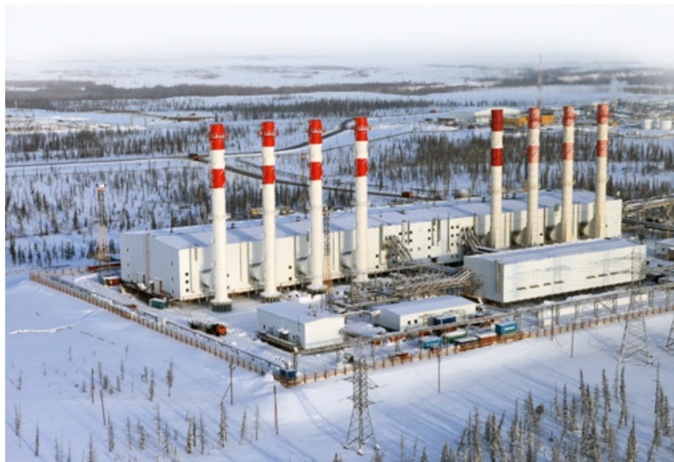
▲ Газотурбинная электростанция на Ванкорском месторождении
